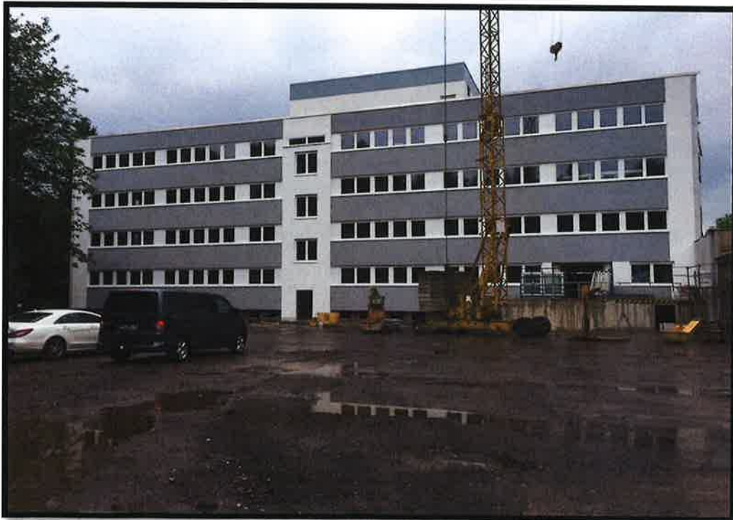
Rückseite des Gebäudes
